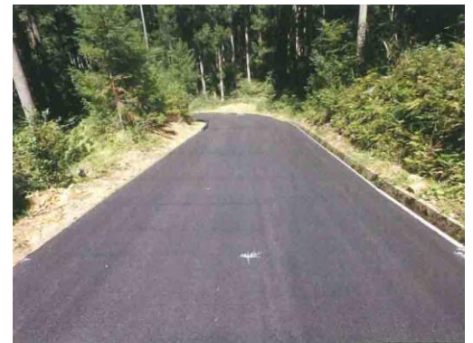
林道荒尾塩津線 舗装状況
