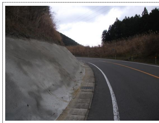
東納庫地区 農道(法面)改良工事 完了
