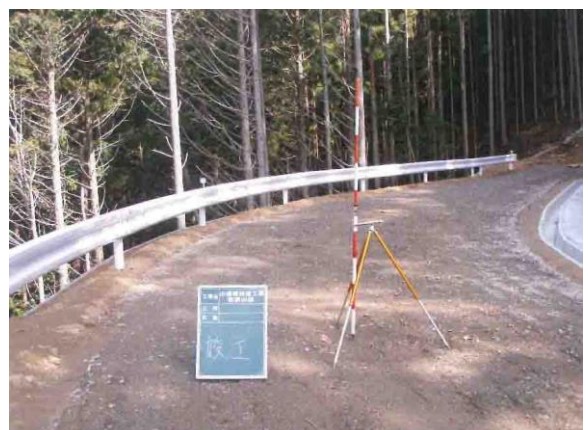
林道笹頭山線 開設状況
