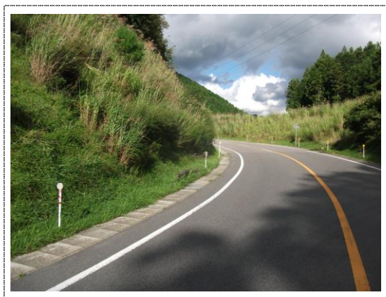
東納庫地区 農道(法面)改良工事 着手前
